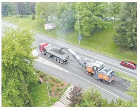
■ Začala oprava vozovky na ulici Zborovské.
