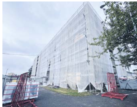
■ Rekonstrukce bývalé budovy technických služeb.
