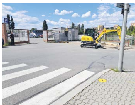
■ Začala revitalizace sportovního areálu.
