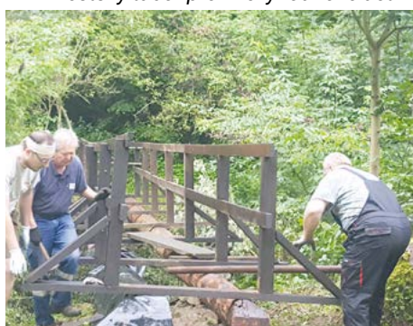
■ Studánková lávka na Putníku prošla obnovou.
