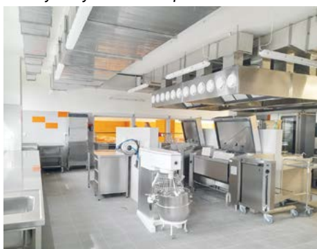
■ Kuchyně a jídelna na Dlouhé po rekonstrukci.
